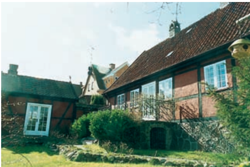
Rughavebus med det lille atelier til venstre der før havde ovenlys. Her arbejdede AWL til han måtte flytte i ca. 1925 for at begynde påny i Jylland nær Thisted. Det kraftige kampestensfundament har været en bedrift at bygge i 1920. Foto Henrik Jørgensen.
